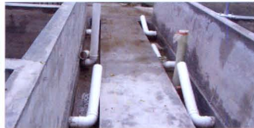
中间走道与排水沟
